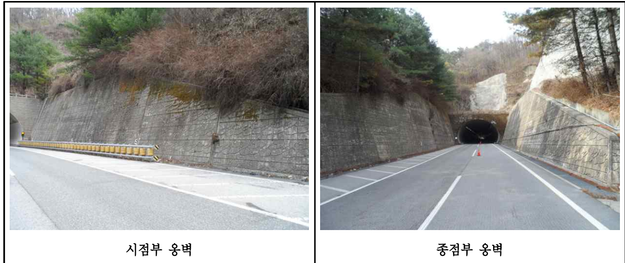
【사진 3.3.15】 옹벽 전경
