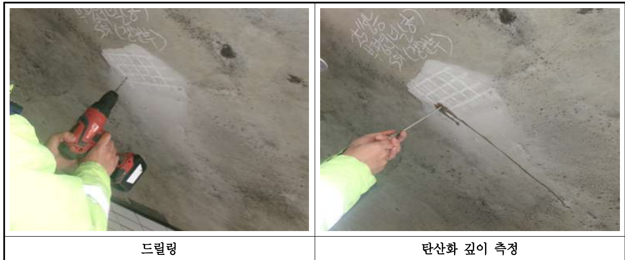
【사진 3.4.2】 탄산화 깊이 시험 현장사진
