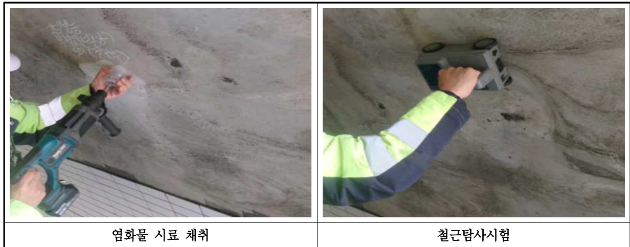
【사진 3.4.3】 염화물 침투량 시험 현장사진
