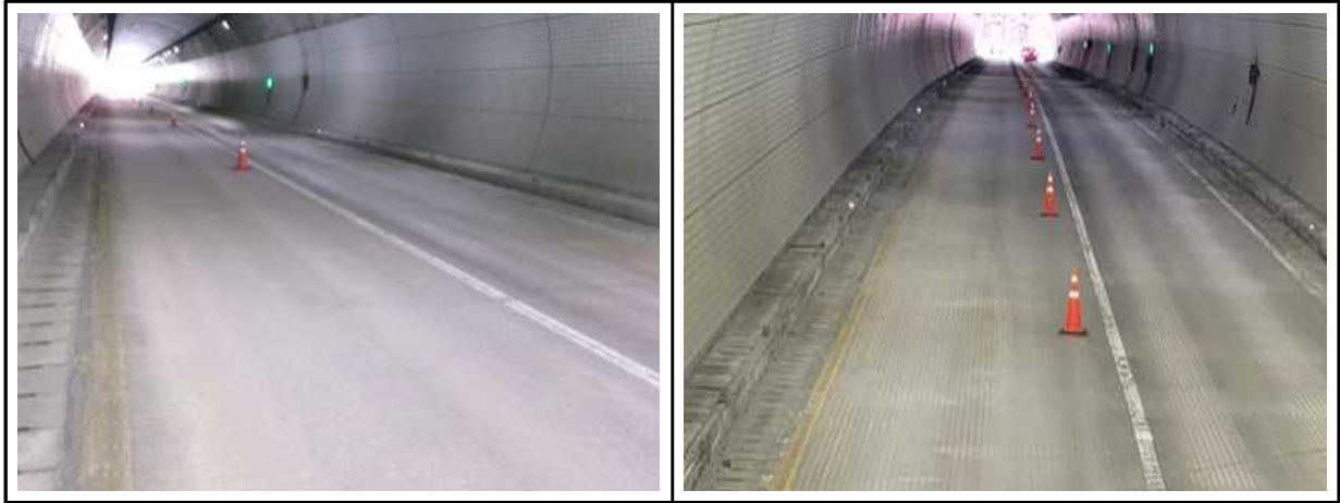
【사진 3.3.11】포장부 전경
