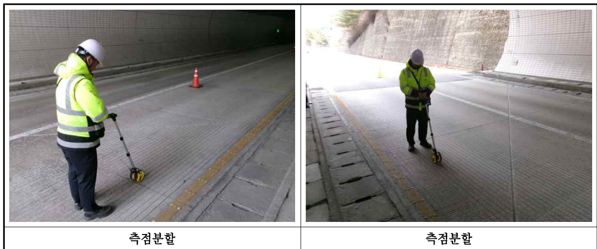
【사진 3.5.1】 측점분할 현장사진
