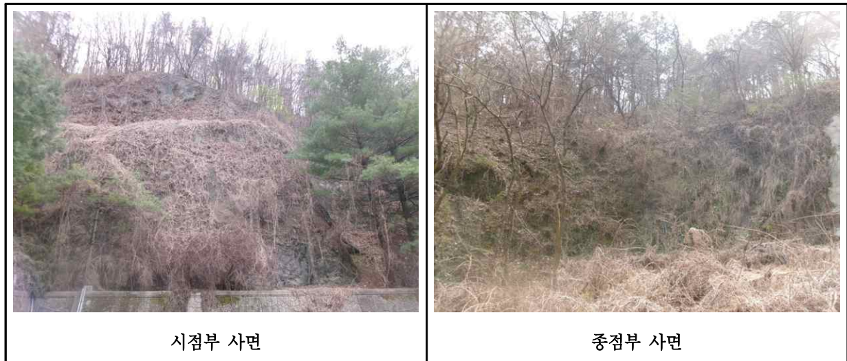
【사진 3.3.13】 사면 전경
