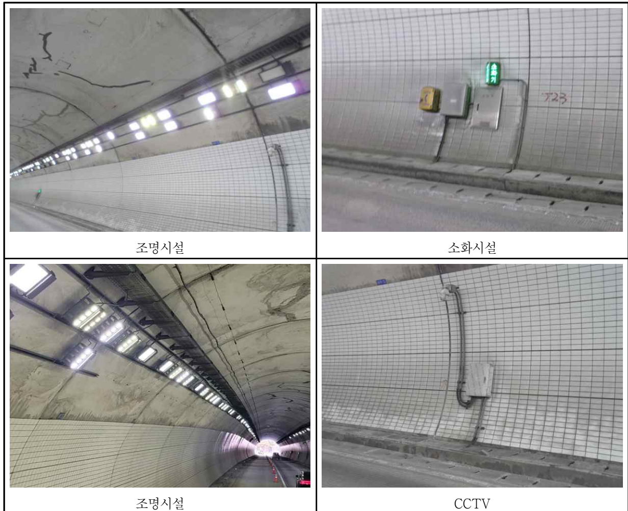
【사진 3.3.17】 부속시설 전경
