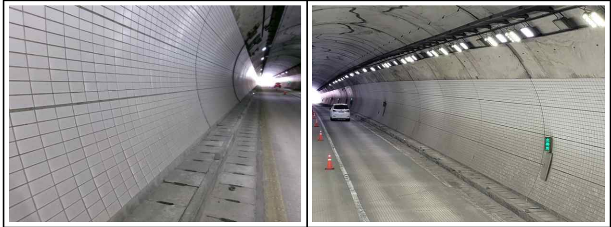
【사진 3.3.3】측벽부 전경
